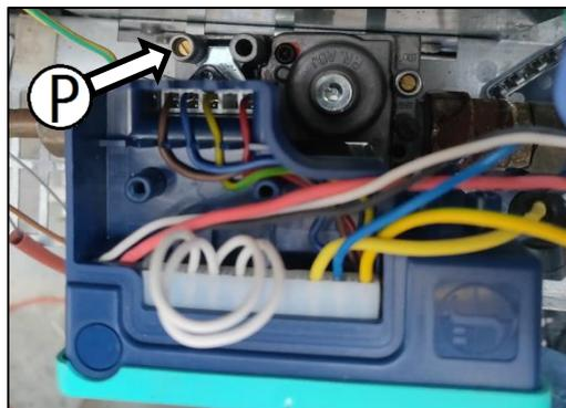
Dopo aver misurato la pressione di allacciamento, scollegare il tubo flessibile del manometro e riavvitare la vite di tenuta della presa di pressione "P".
